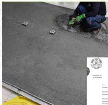
船舶用床材の施工の様子
