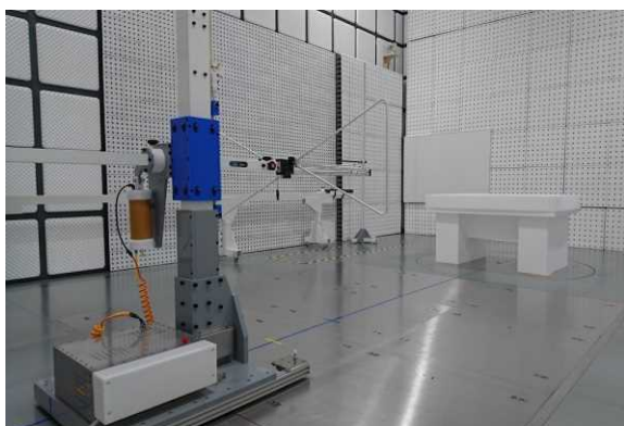
(株) リケン環境システム製 電波暗室
